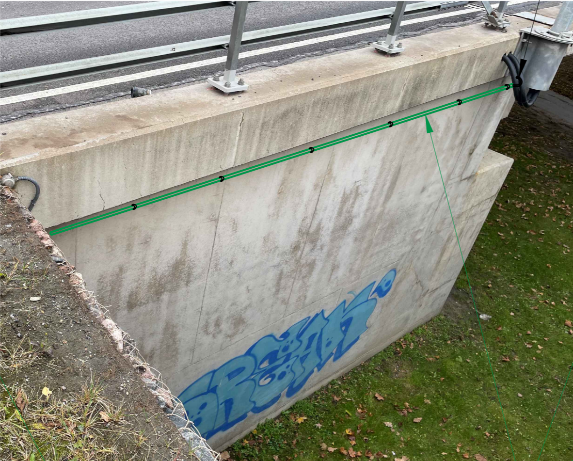
Kaabel raudbetoonkonstruktsioonil alumiinium torus (D20, kinnituste vahekaugus <=2m)
